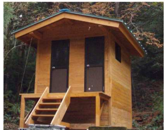
▲バイオトイレ外観
