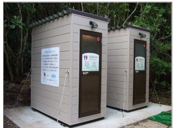
▲小笠原父島に設置された環境保全型トイレ
